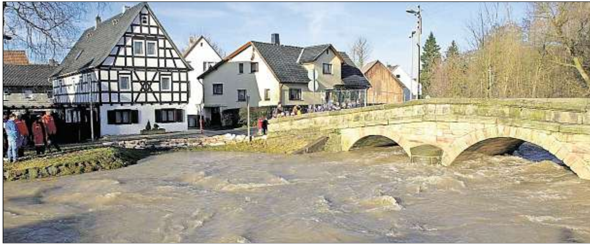
Die Heubischer Brücke, als sie noch die Steinach überspannte. Mangelnde Wartung führte zu Schäden und Abriss. Eine von vielen Ideen ist, die alte Brücke als Fußgängerbrücke vor die neue zu stellen. Foto: camera900.de
