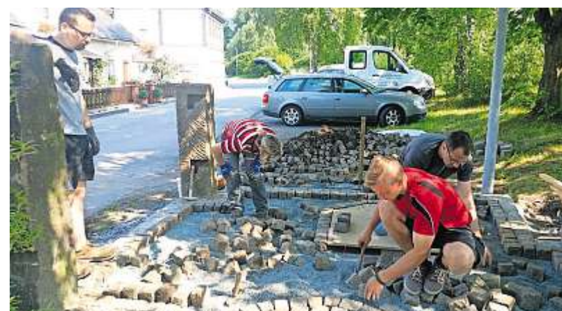
Sebastian Greiner, Franz Blaufuß und Matthias Schelhorn pflastern den Platz, auf dem der Dorfbrunnen jetzt wieder neu erstrahlt.
